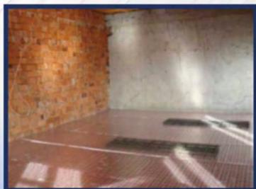
**1. Укладка изоляции и арматурной сетки.** В качестве изоляционного материала рекомендуем использовать мат из пенополистирола (плотность 25,1 – 35 кг/м<sup>3</sup>), ламинированный алюминиевой фольгой. Затем на слой теплоизоляции укладывается арматурная сетка, к которой при помощи хомутов прикрепляется труба. Помимо удобного способа разметки, сетка является еще и армирующим элементом будущей стяжки.
